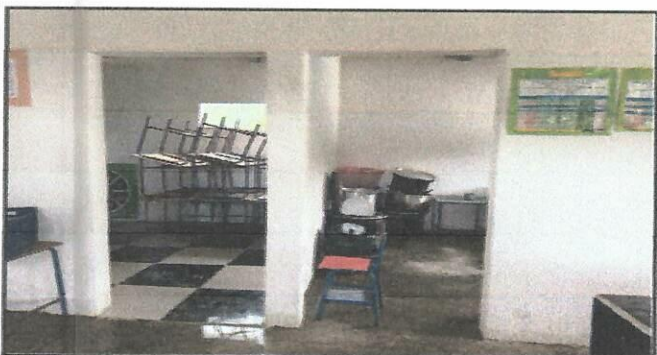
Foto 3: Instalación de puertas
