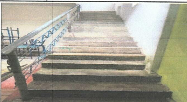
Foto 2: Instalación de piso en gradass ( antedslizante)
