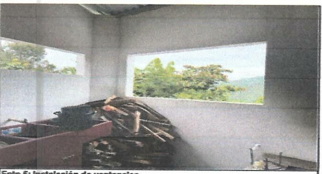
Foto 5: Instalación de ventanales
