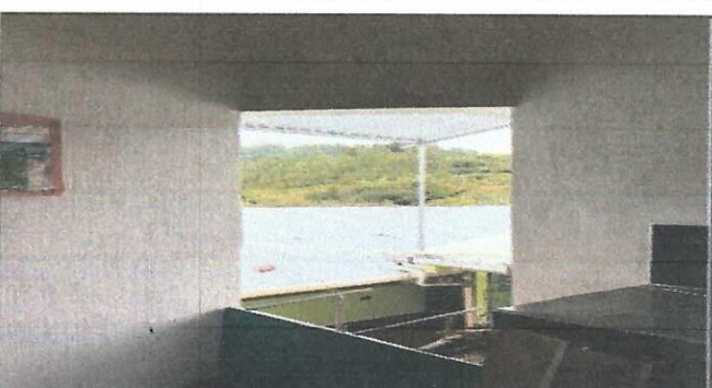
Foto 4: Instalación de puertas
