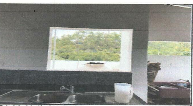
Foto 6: Instalación de ventanales
